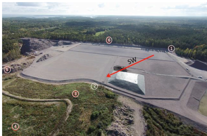
Figur 1. Provpunkter för mätning av metalldeposition vid Storskogens deponi.
