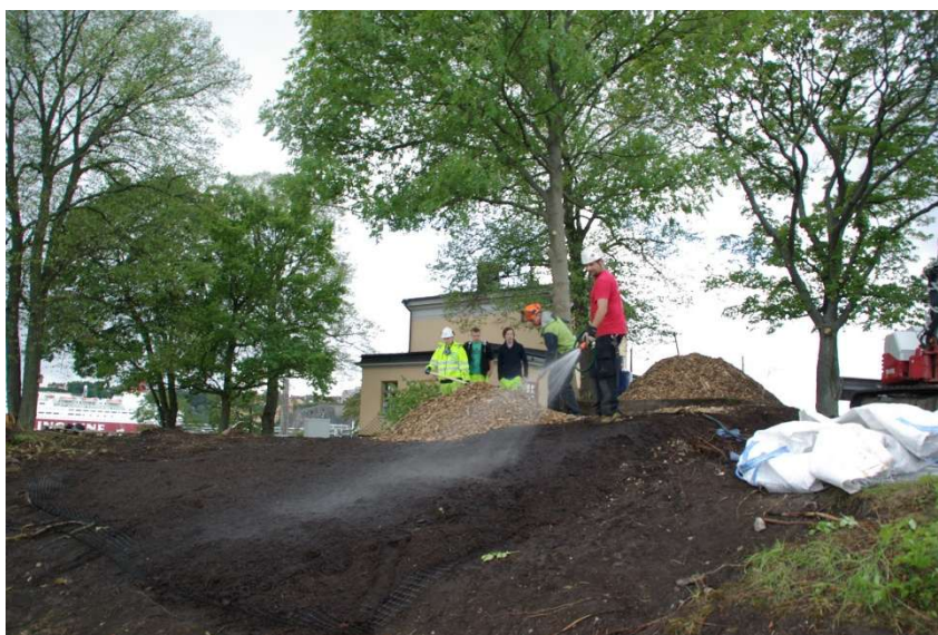
Figur 9. Nytt jordlager läggs på framtager rotsystem. Foto Örjan Stål.
