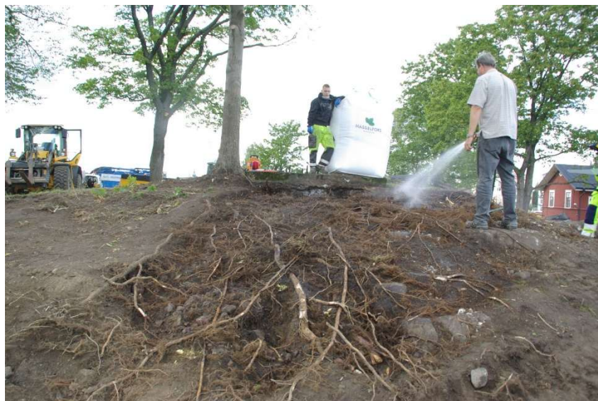
Figur 7. Framtagna rötter ska hållas fuktiga till återfyllnad skett. Foto Örjan Stål.
