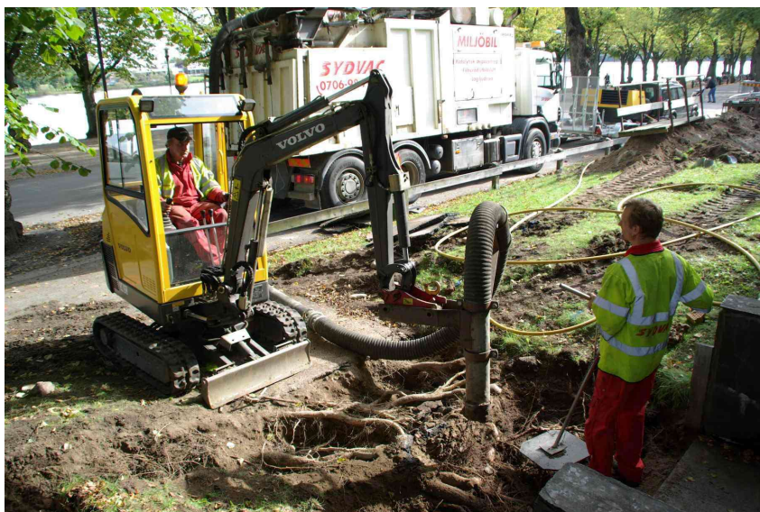
Figur 6. Varsam schakt där jorden sugs upp med slang som är monterad på en liten grävmaskin, med assistans av tryckluftslans. Jordmassorna sug in i behållaren på vakuumlastbilen. Foto Örjan Stål.
