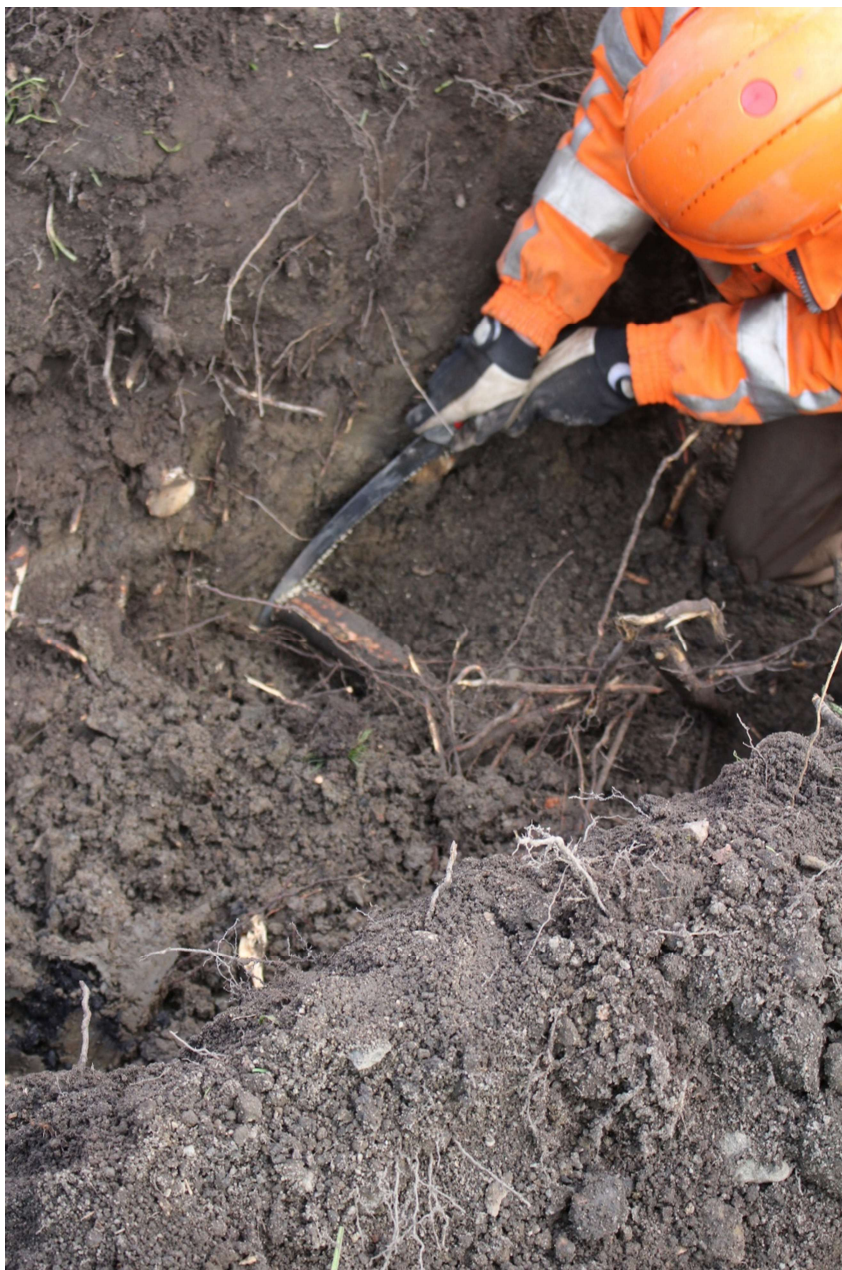
Figur 13. Rötter som ska avlägsnas i kanten av skyddszonen ska beskäras med avsedda beskärningsverktyg. Foto Örjan Stål.
