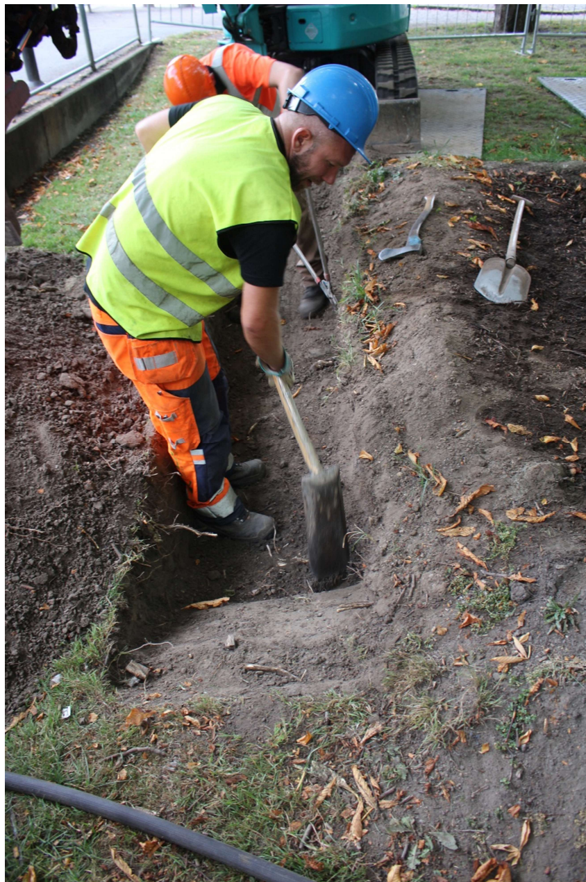
Figur 12. Försiktig schakt med konventionell grävmaskin med assistans av spade för att lokalisera grövre rötter. Foto Örjan Stål.
