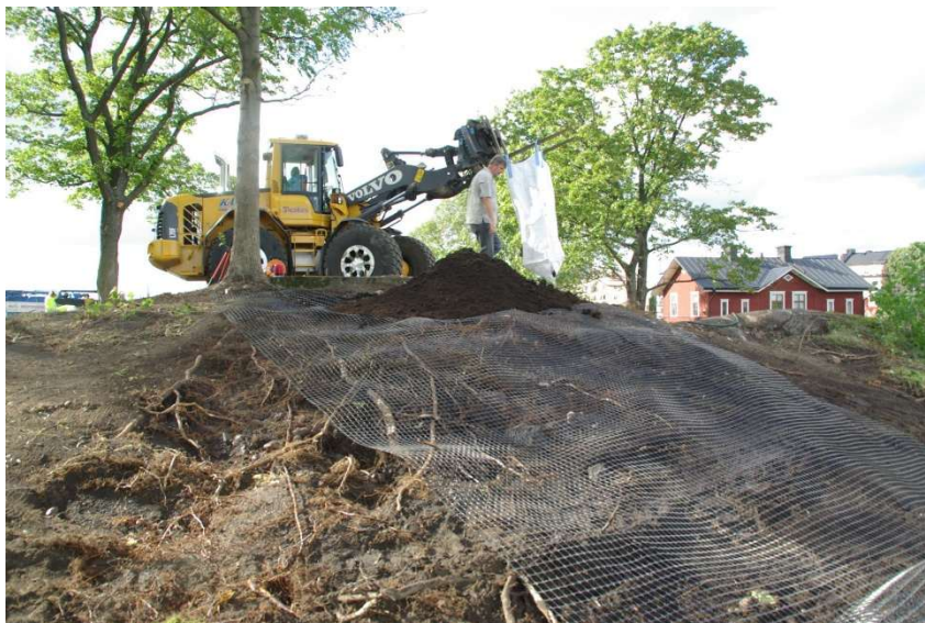
Figur 8. Ett geonät läggs på rotsystemet som markering att det finns markföroreningar kvar under rotsystemet. Foto Örjan Stål.
