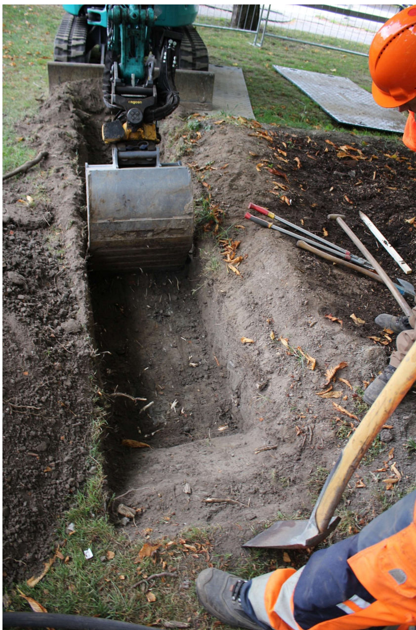
Figur 11. Försiktig schakt med konventionell grävmaskin som kan utföras ytligt inom skyddszonen eller i kanten av till skyddszonen. Foto Örjan Stål.
